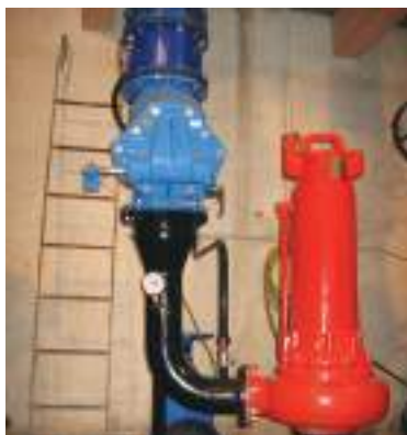
VÁLVULA DE RETENCIÓN A CLAPETA CON CONTRAPESO
