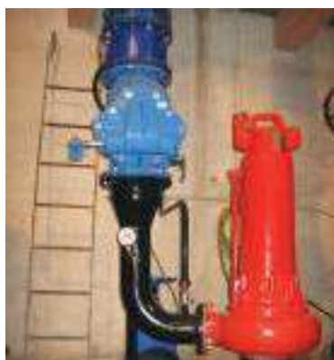
VÁLVULA DE RETENCIÓN A CLAPETA CON CONTRAPESO
